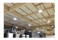
CO2削減に向けて、2014年9月に本社工場の水銀灯 120灯を LED 照明に切り替えました。これにより年間約11万 kWh の電力量と 60t のCO2が削減できます。また、11月には全館の空調を重油式からヒートポンプ式(電気)に切り替え、環境負荷低減を図りました。日進堂グループは今後もCO2抑制に向けて積極的に環境活動を推進し、エコな企業として地域に貢献していきたいと考えています。
